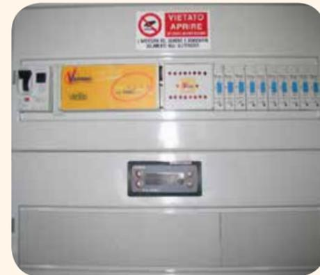
**Sistema taglio picchi per il collegamento di n° 8 (otto) apparecchiature composto da:**
